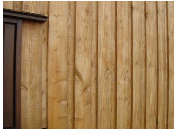
カラマツ大和張りの外壁
