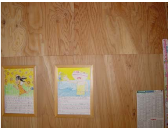
カラマツ構造用合板の壁
