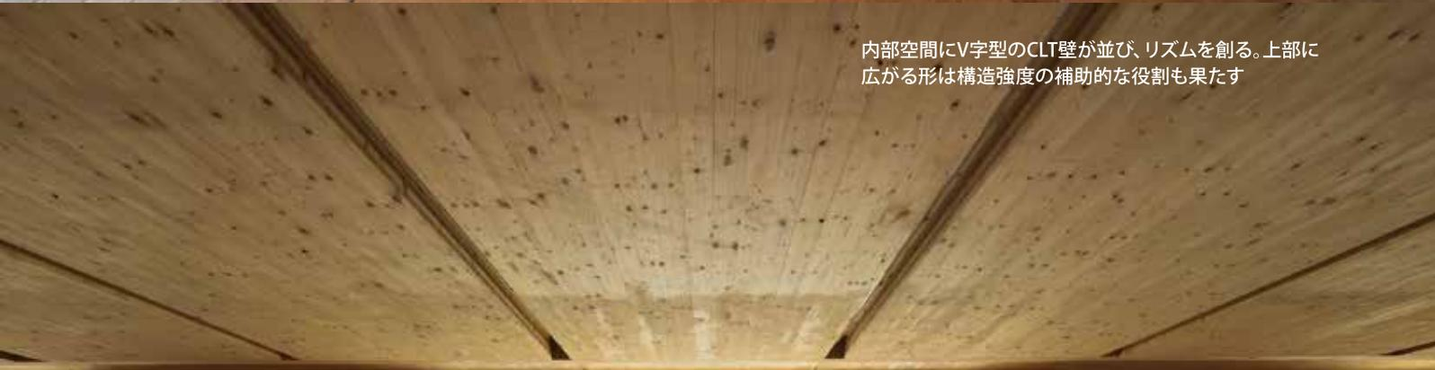
内部空間にV字型のCLT壁が並び、リズムを創る。上部に広がる形は構造強度の補助的な役割も果たす
