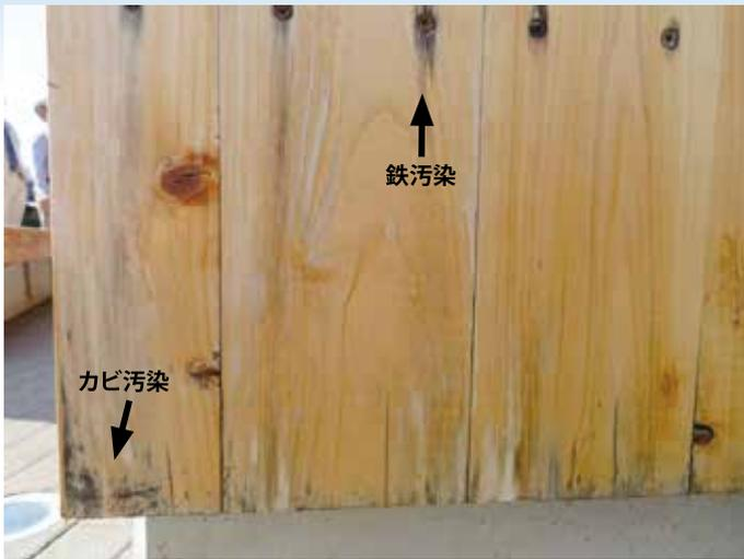
図2 外装木材の鉄汚染とカビ汚染
