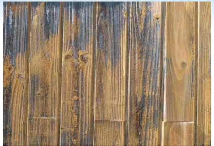
図4 含浸形木材塗料の劣化が進行した外装木材
