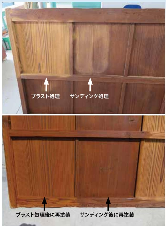
図7 ブラスト処理による旧塗膜剥離の効果
