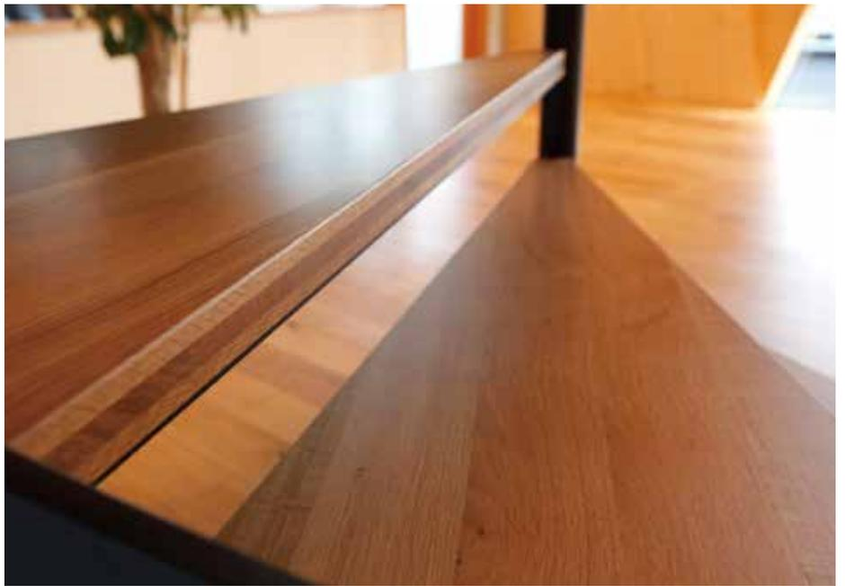
[上写真] ナラCLTを使用した螺旋階段の段板。躯体以外にもCLTを活用している
