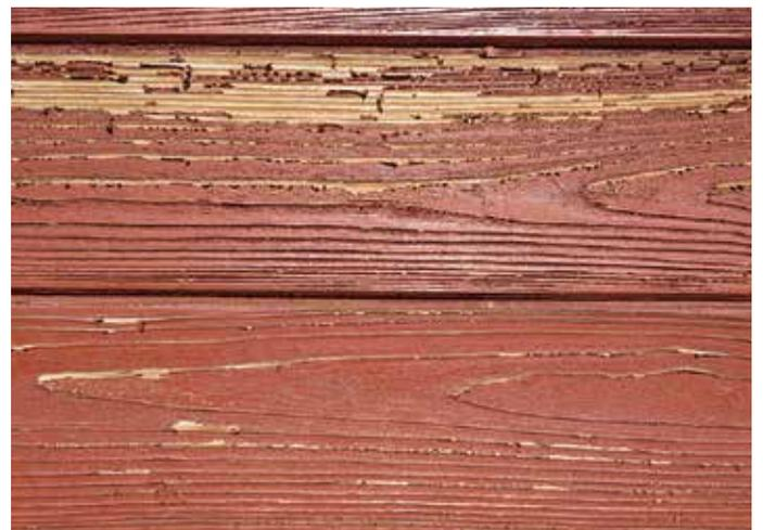
図6 造膜形塗料のはがれが進行した外装木材
