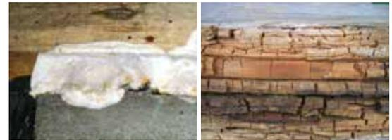
図4 土台上に繁茂する腐朽菌菌糸(左)と褐色腐朽材の外観(右)
