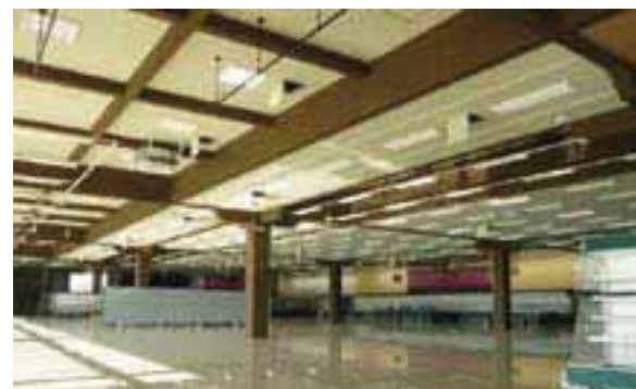
カラマツ大断面集成材の柱と梁が特徴的な店舗フロア
