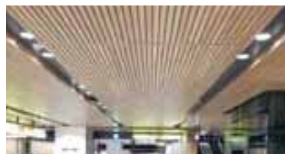
天井に施工された準不燃内装材
