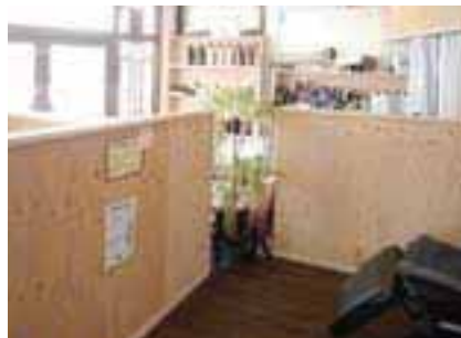
内装には白色塗装された道産カラマツ合板
