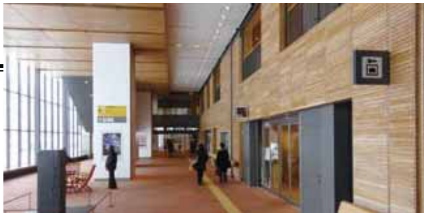
駅舎内の壁面と天井に広がる道産ヤチダモ内装材
