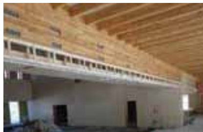
エントランスホール、梁（カラマツ集成材）・下地材（トドマツ製材）
