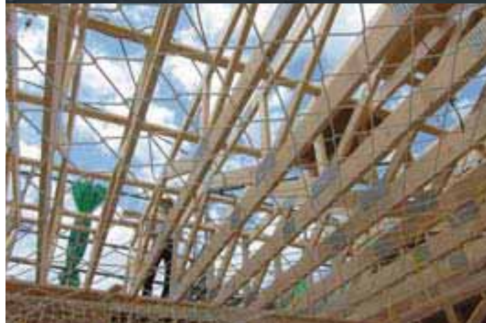
〔右上写真〕店内カウンター 〔右下写真〕道産トドマツ製材 〔上写真〕竣工 〔左写真〕屋根トラス
