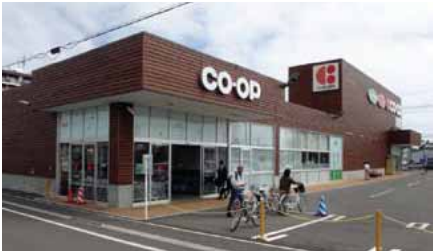
〔上写真〕ECO・OP さつない店（幕別町） 〔下写真〕ECO・OP 新橋大通店（釧路市） 両店舗とも外壁にカラマツ材を使用
